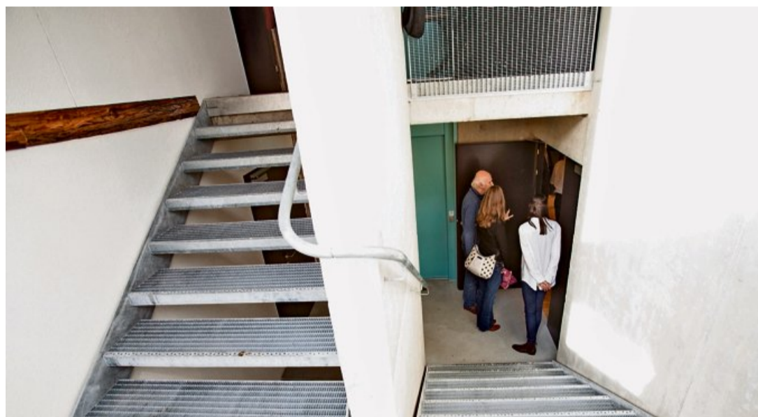
Ein Treppenhaus verbindet zwei verschiedene Bauten – den Neubau und das Rebbauernhaus.
